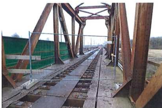
b) Chýbajúce zabezpečenie okrajov výkopov a nebezpečných plôch proti pádu osôb
