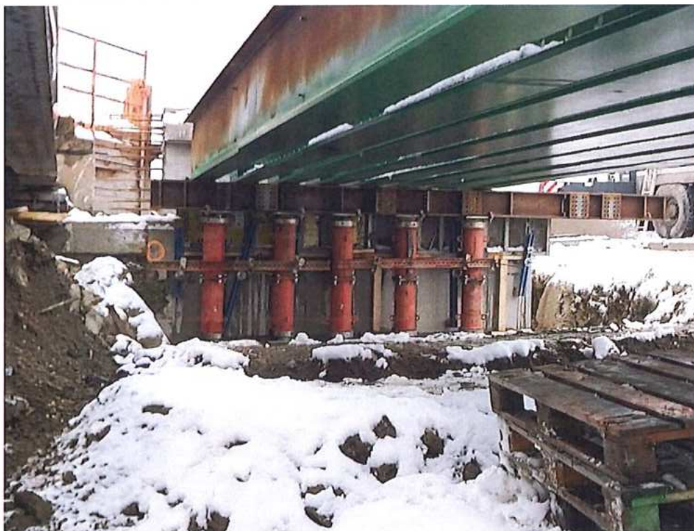
Podperná konštrukcia a osadenie nosníkov – SO 12-33-01
