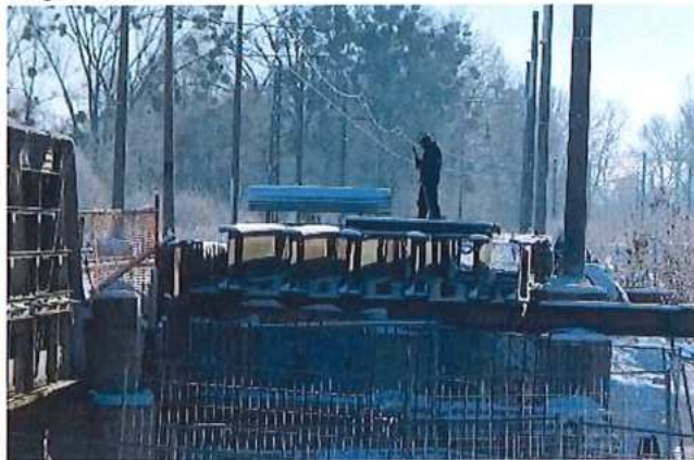
c) Pracovné komunikácie nie sú v súlade s pravidlami BOZP
