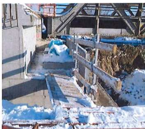
c) Pracovné komunikácie nie sú v súlade s pravidlami BOZP
