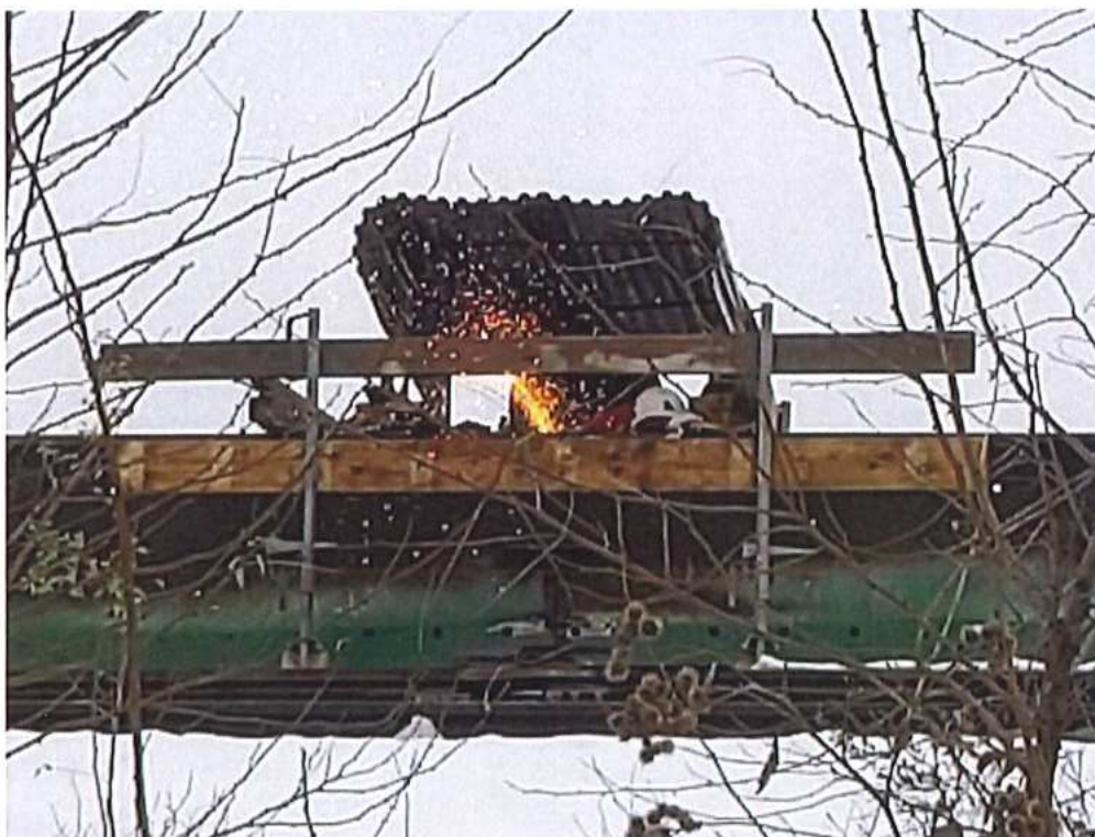
Zváranie nosníkov (obrusovanie zvarov) – SO 12-33-02
