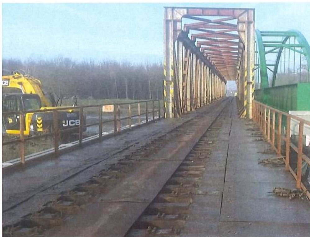
Demontáž žel. zvršku na moste – SO 12-33-04
