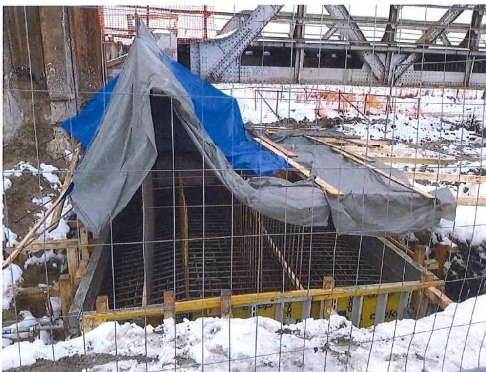
Armovanie základu č. 3 (príprava na betonáž) – SO 12-33-02
