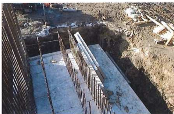
c) Pracovné komunikácie nie sú v súlade s pravidlami BOZP
